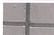
可塑剤が気化した塗膜部分
